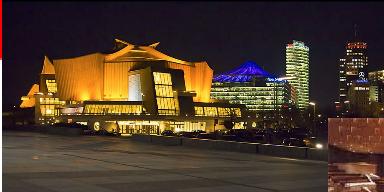
La façade extérieure Die äußerliche Fassade
