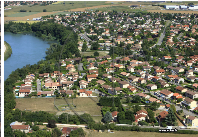
Meyzieu (espace périurbain de Lyon)
