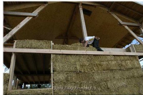
Installation de l'isolation paille
