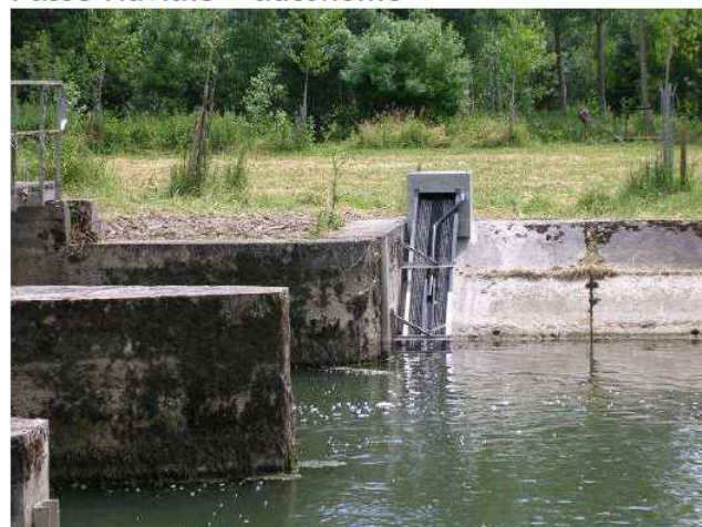
Fig.4 : passe à anguille de l'Ouchette sur la Vieille Sèvre
