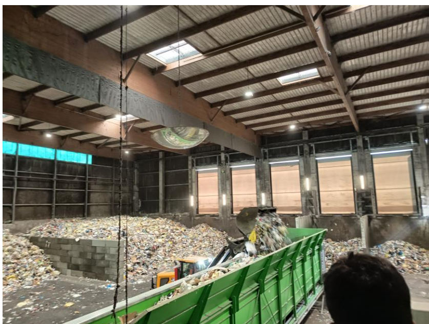
Déchargement des déchets de la poubelle jaune.
