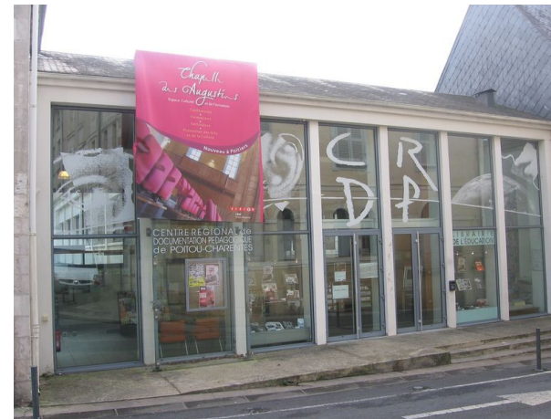
La façade du CRDP
